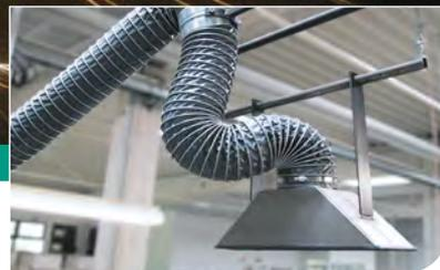
Gaines pour climatisation, ventilation et fumées de soudage
